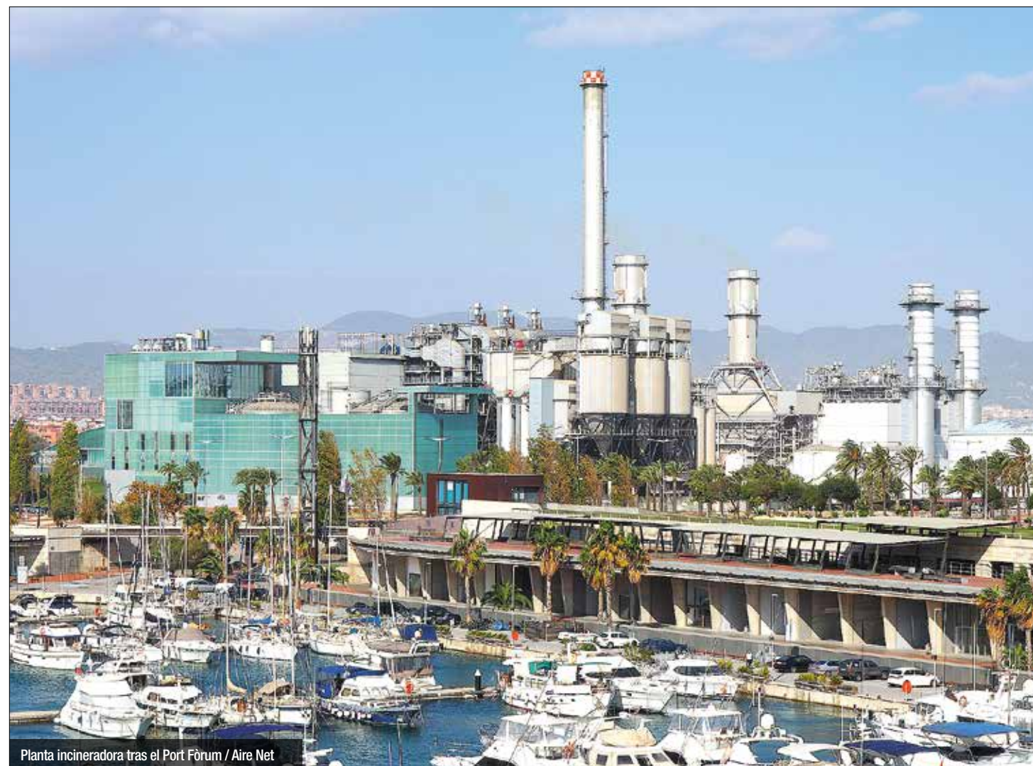
Planta incineradora tras el Port Fòrum / Aire Net
