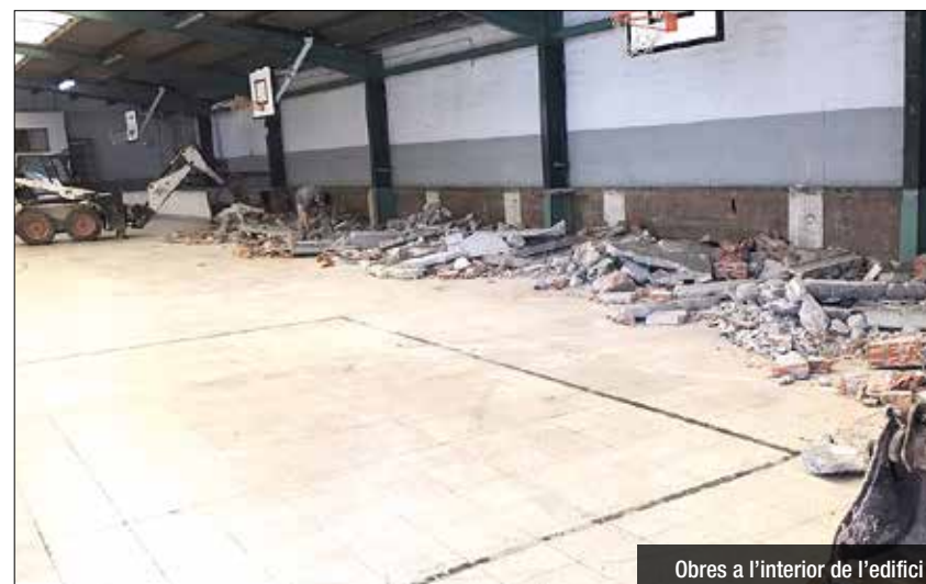
Obres a l'interior de l'edifici
