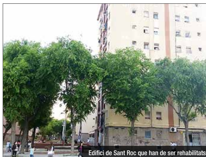
Edifici de Sant Roc que han de ser rehabilitats
